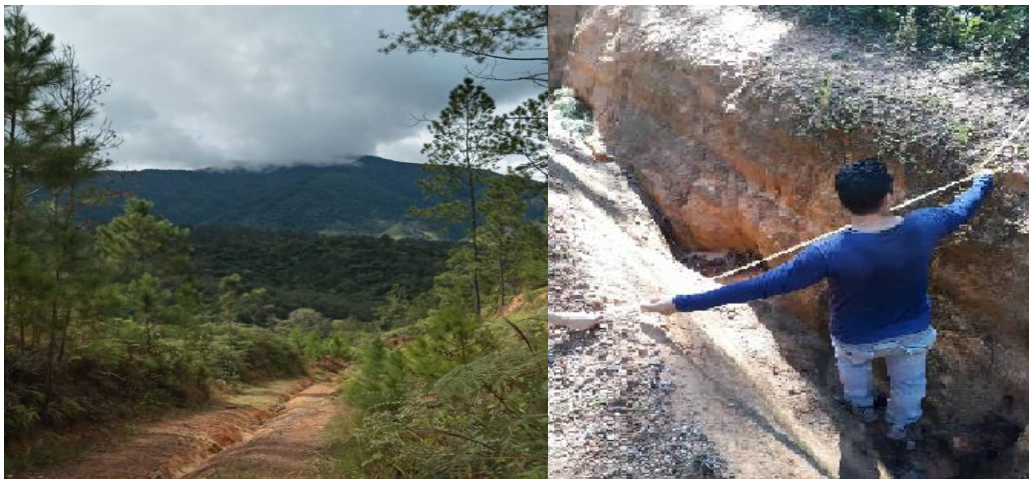
Figura 5. Erosión causada por el agua
