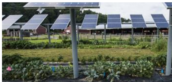
Figura 4. Sistema agrovoltaico con vegetales en el Research and Education Center en Massachusetts
