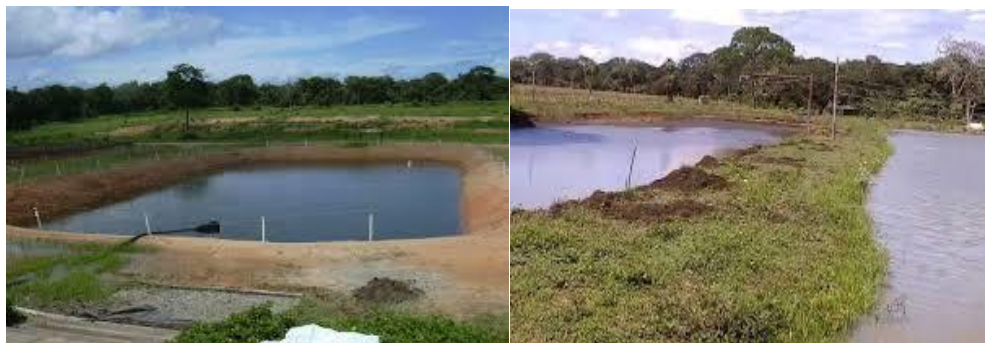
Figuras 8 y 9. Suelos arcillosos aptos para la construcción de los estanques y la cría de peces.
