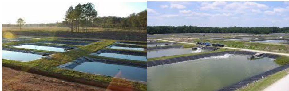
Figuras 11 y 12. Estanques para la cría de peces en condiciones naturales con el empleo de revestimientos.
