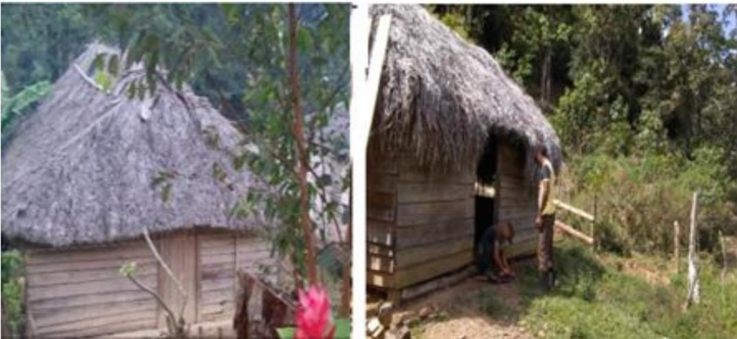
Figura 4 Viviendas construidas con guano y madera
